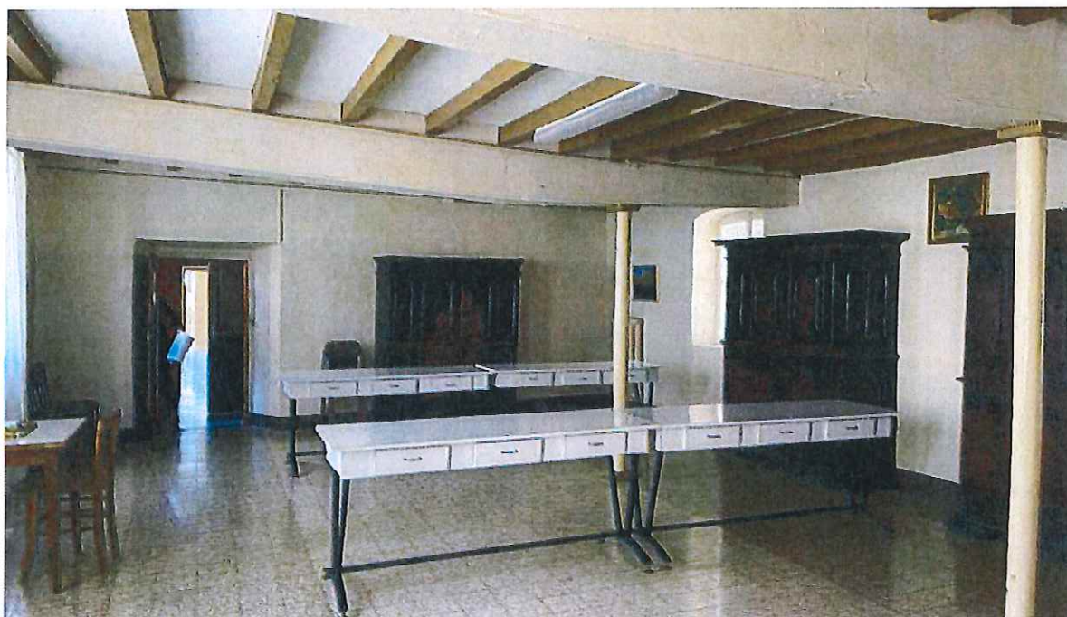
Fig.16 | Primo piano: refettorio. In primo piano le colonne di rinforzo delle travi lignee.
