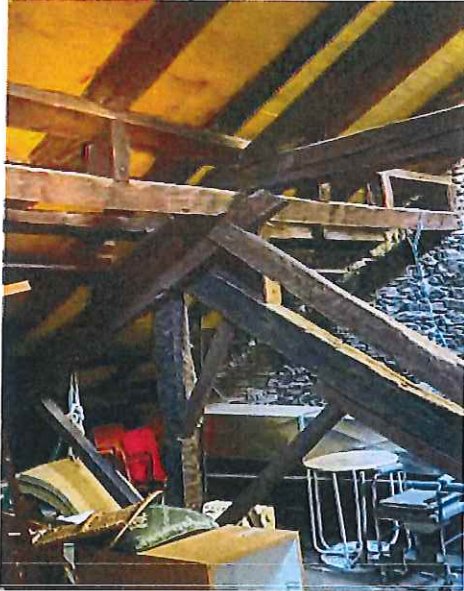
Fig.20 | Capriate della copertura della chiesa.
