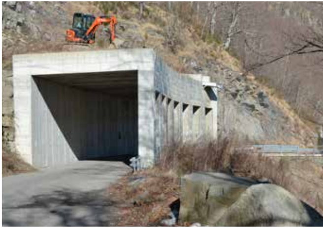
Nuovo tunnel strada Tagliole
