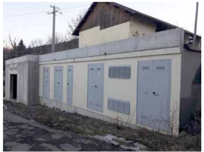
Nuova cabina e sala pompe impianti sciistici
