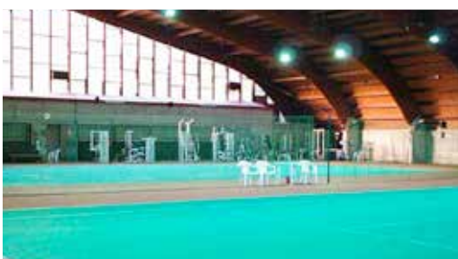
Palazzetto sport, con fotovoltaico sul tetto
