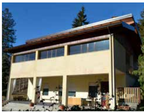
Copertura edificio servizio imp. sportivi
