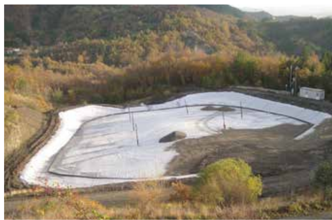
Fase dei lavori discarica Casa Marmocchio
