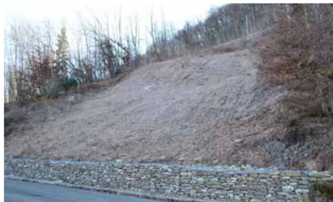
Intervento frana Borra
