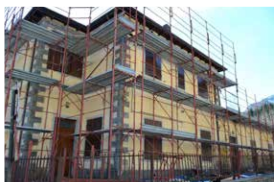
Lavori in corso all'ex scuola / ostello Tagliole
