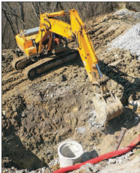
Lavori in corso Via Val di Sasso
