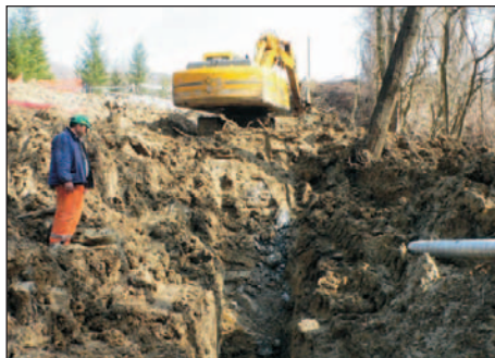
Lavori in corso Via Val di Sasso
