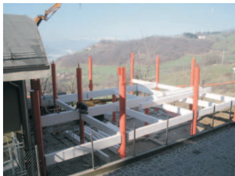
Ampliamento Scuola Materna lavori in corso
