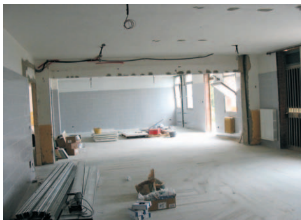
Scuola Materna: ristrutturazione interna edificio esistente
