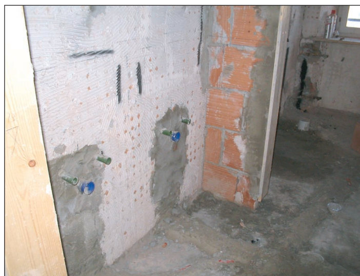
Lavori in corso all'interno dell'ultimo piano
