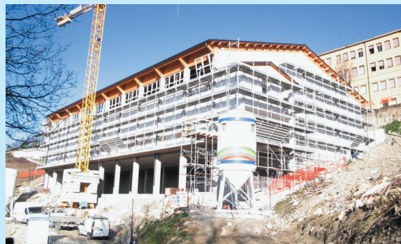
Il cantiere della palestra.
