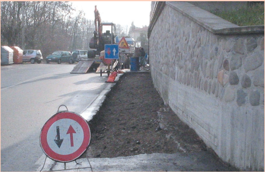
Cantiere di Via Roma.
