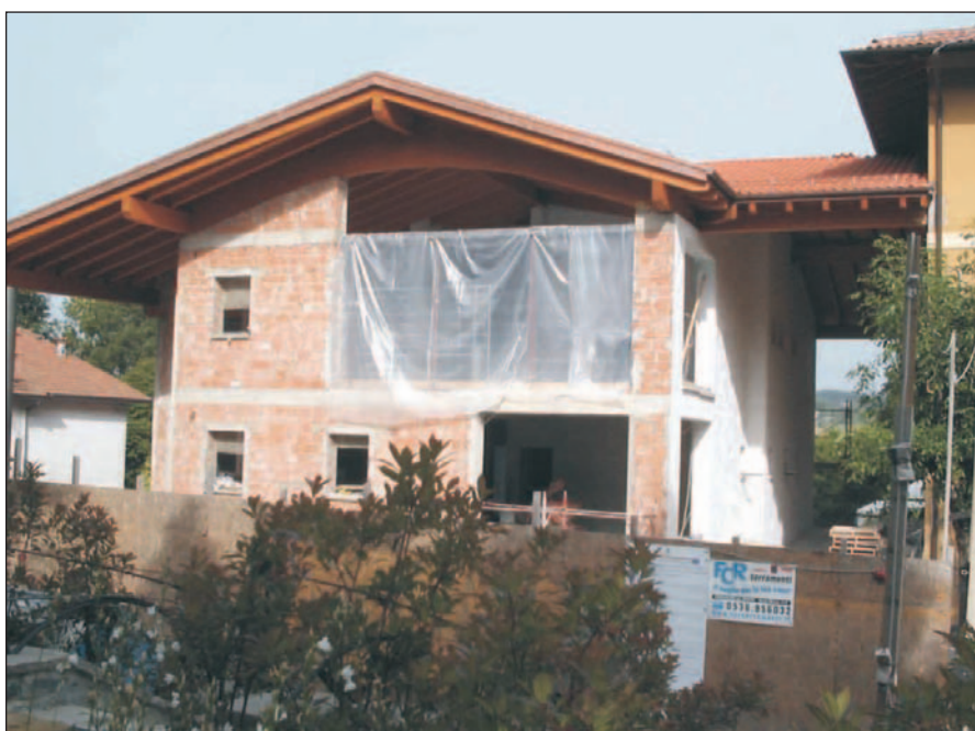
Pabbricato in viale Belvedere
