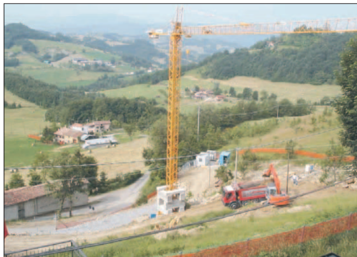
Palestra polivalente: lavori in corso
