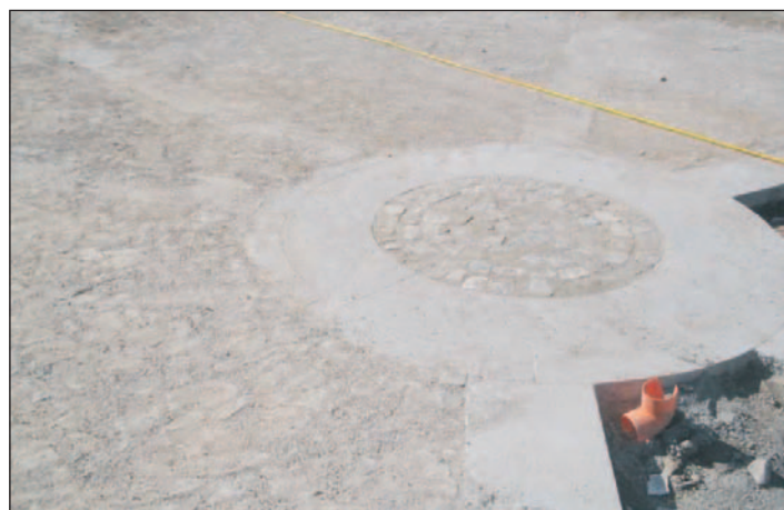
Fase di esecuzione del centro della piazza
