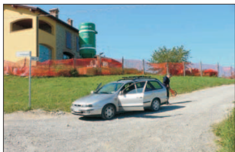
Lavori viari in via Redipuglia
