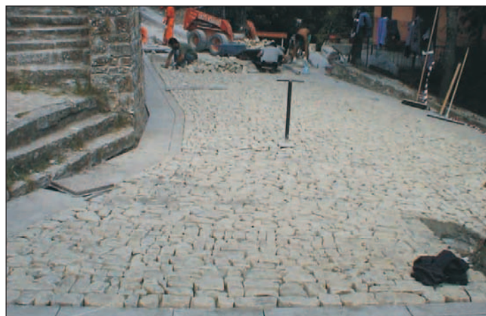
Particolare della pavimentazione dell'intervento
