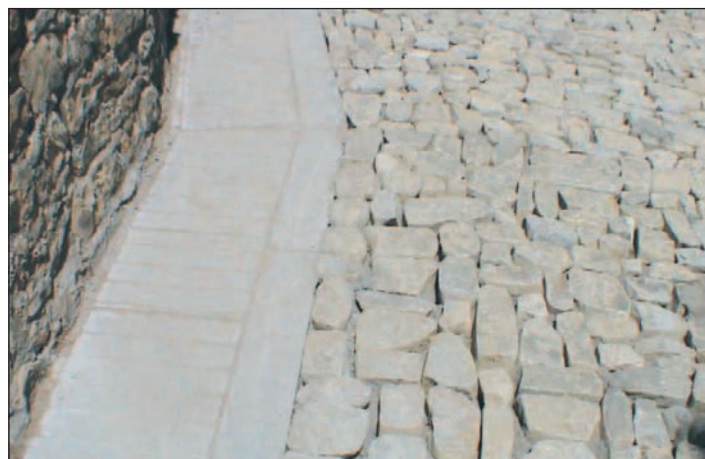
Fase di esecuzione del perimetro della piazza
