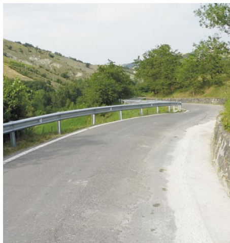
Via Valle - Olio a lavori eseguiti
