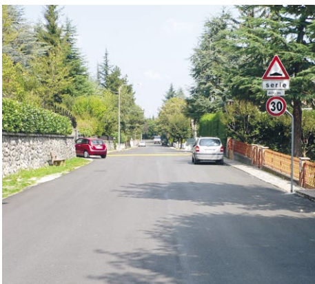
Viale delle Nazioni a lavori eseguiti
